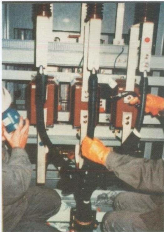
ニシチューブ利用の端子接続部のカバー(NPE)
