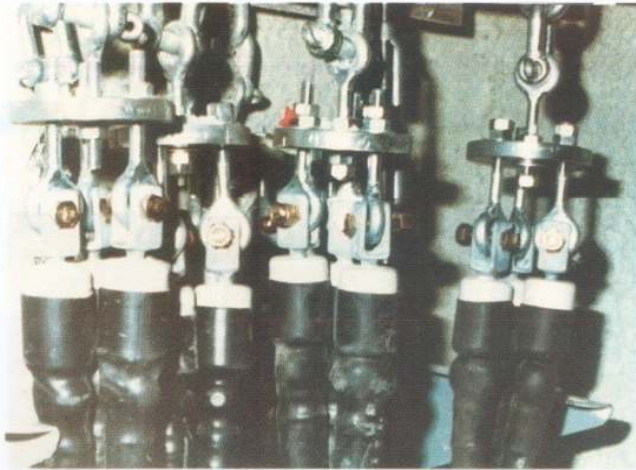
ビル用ケーブルの吊り下げ部(NPE)
