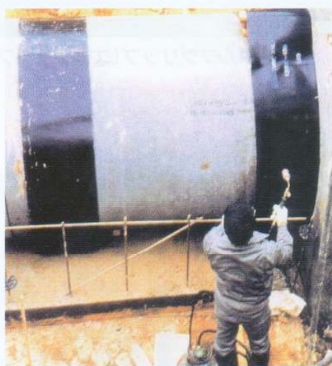
ヒューム管継手部防水 ニシチューブ(NXL-HC(C))
