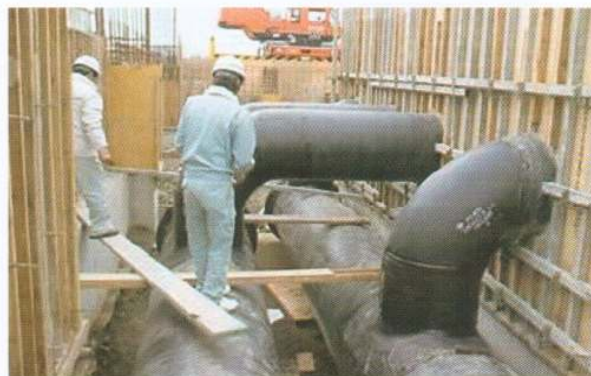
大口径鋼管防食用チューブ(NXL)
