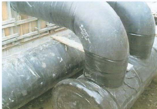
大口径鋼管防食用チューブ(NXL)
